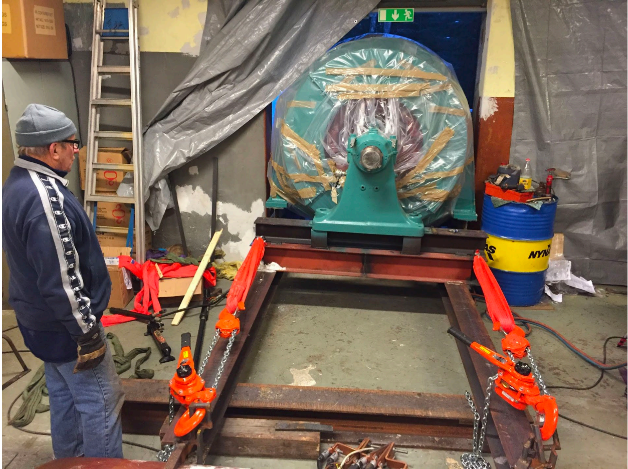
Den nyrenoverade generatorm lanseras in i maskinhallen. Inte mycket utrymme tillgodo.
