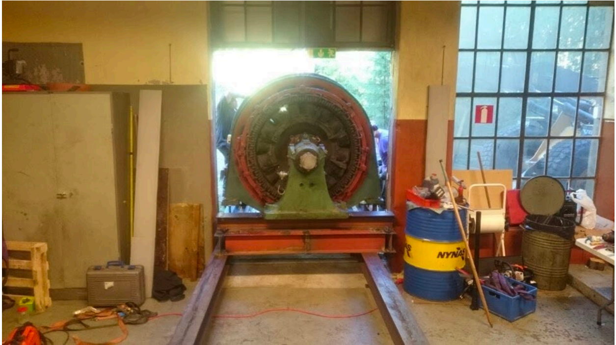
Generatoren dras ut för transport och reovering.
