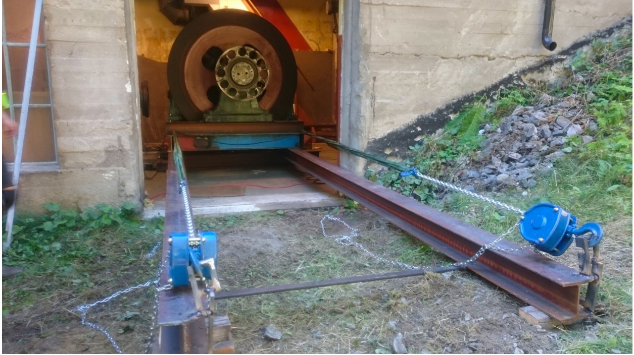
Generatorn dras ut på balkar.
