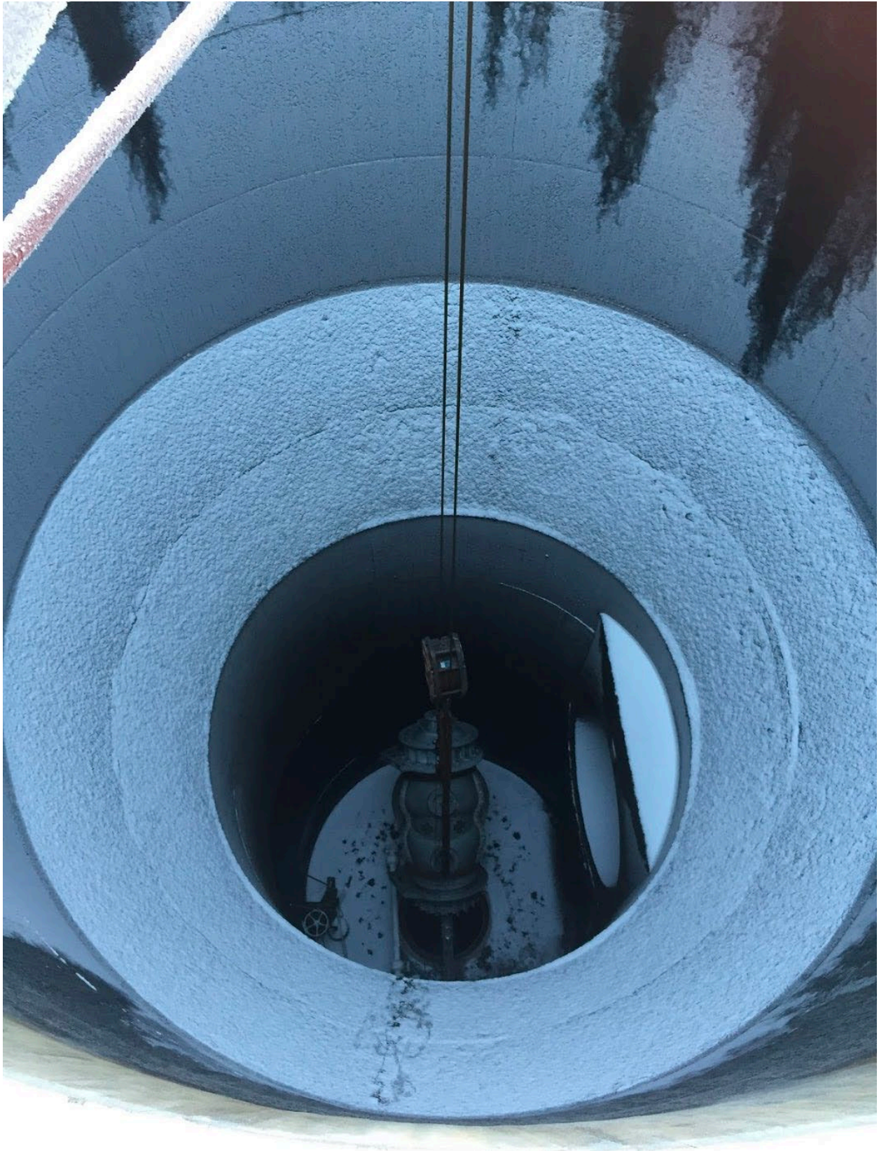
Turbinen sänks ner i vattentornet efter renovering.
