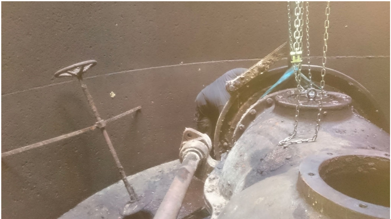
Förberedelse för lyft av turbinen.
