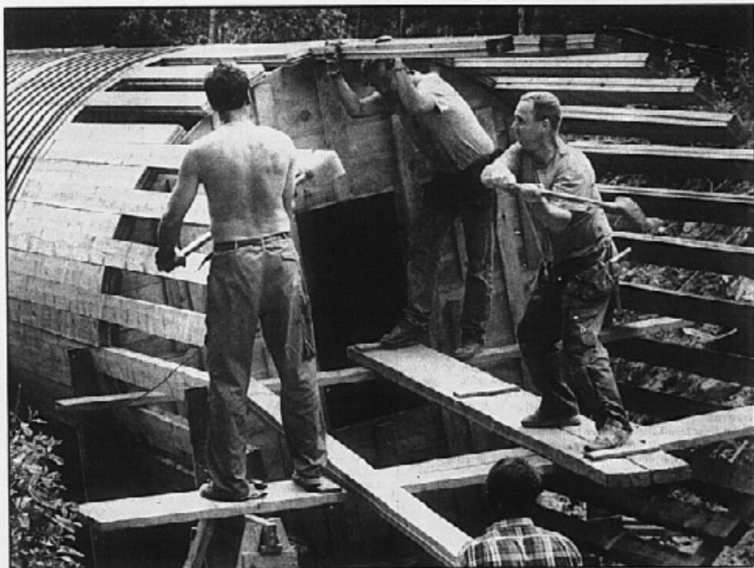
Arbetet i full gång. Med en slögga som väger fem kilo får man den sista biten av plankan.
