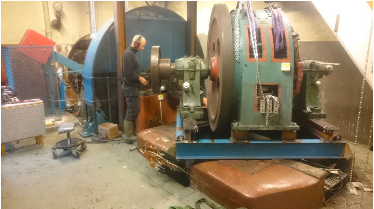
Generatorn görs i ordning för att lyftas ut.
