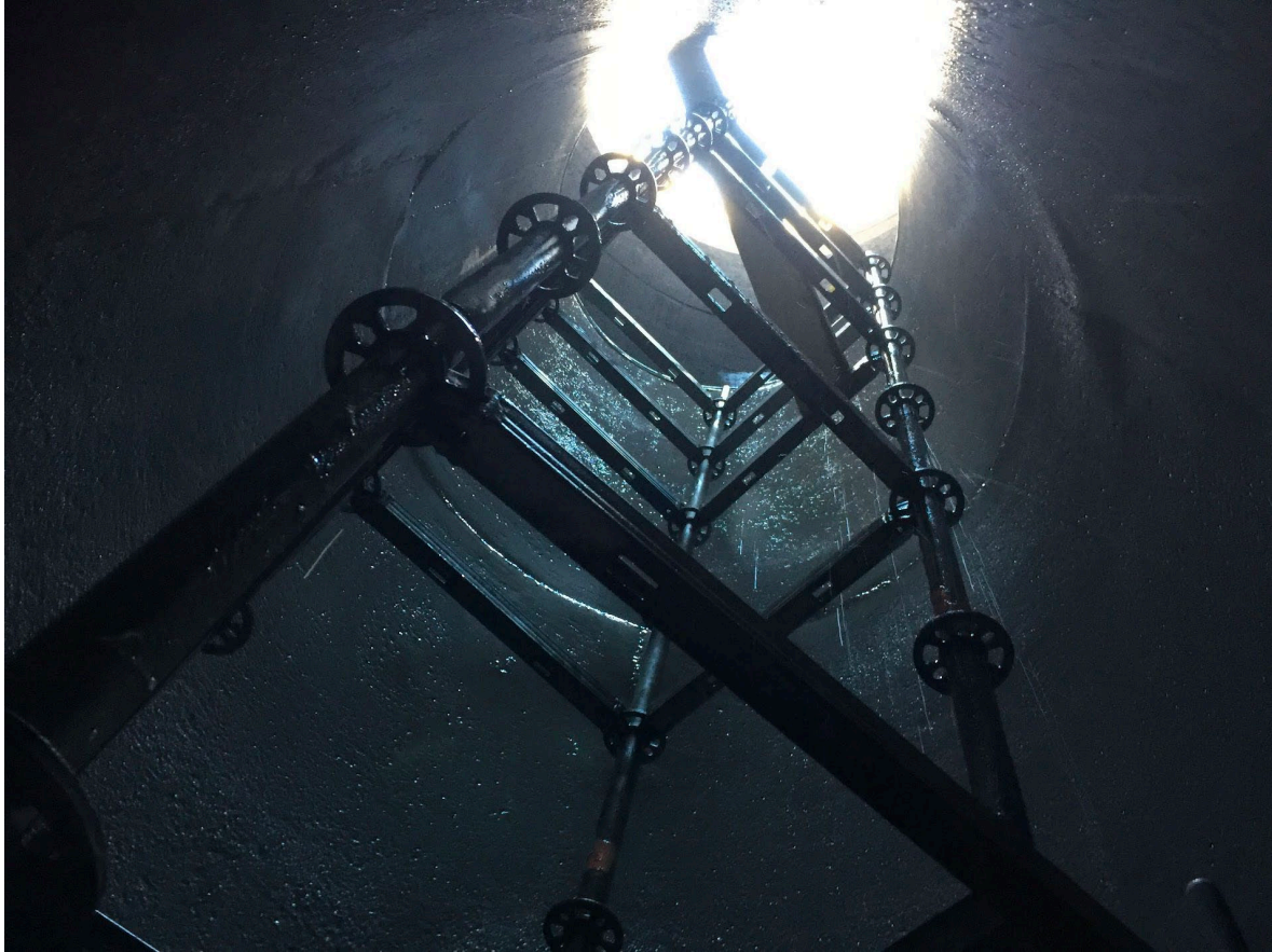
Ställning i sugröret som målats.
