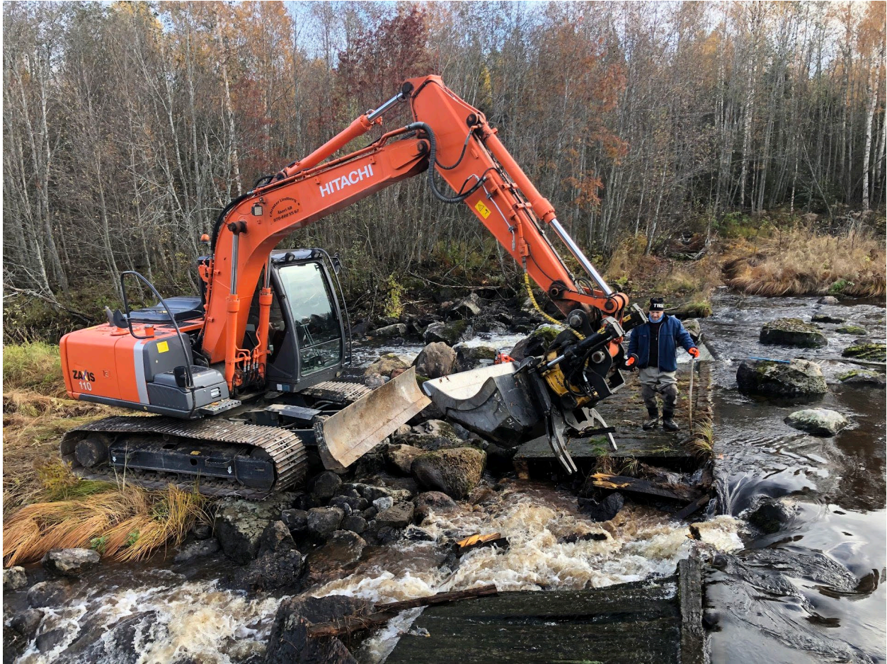
Bo Öhman leder byggandet av omlöp 2019 med ny öppning i skibordet.
