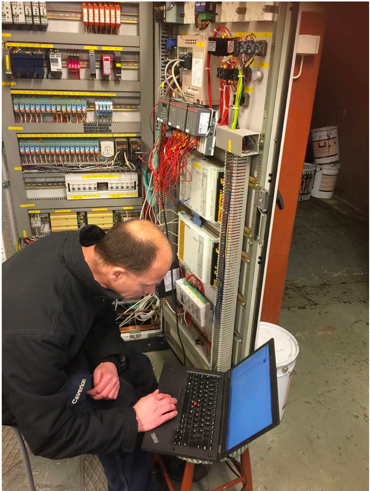
Nytt styrsystem installeras.
