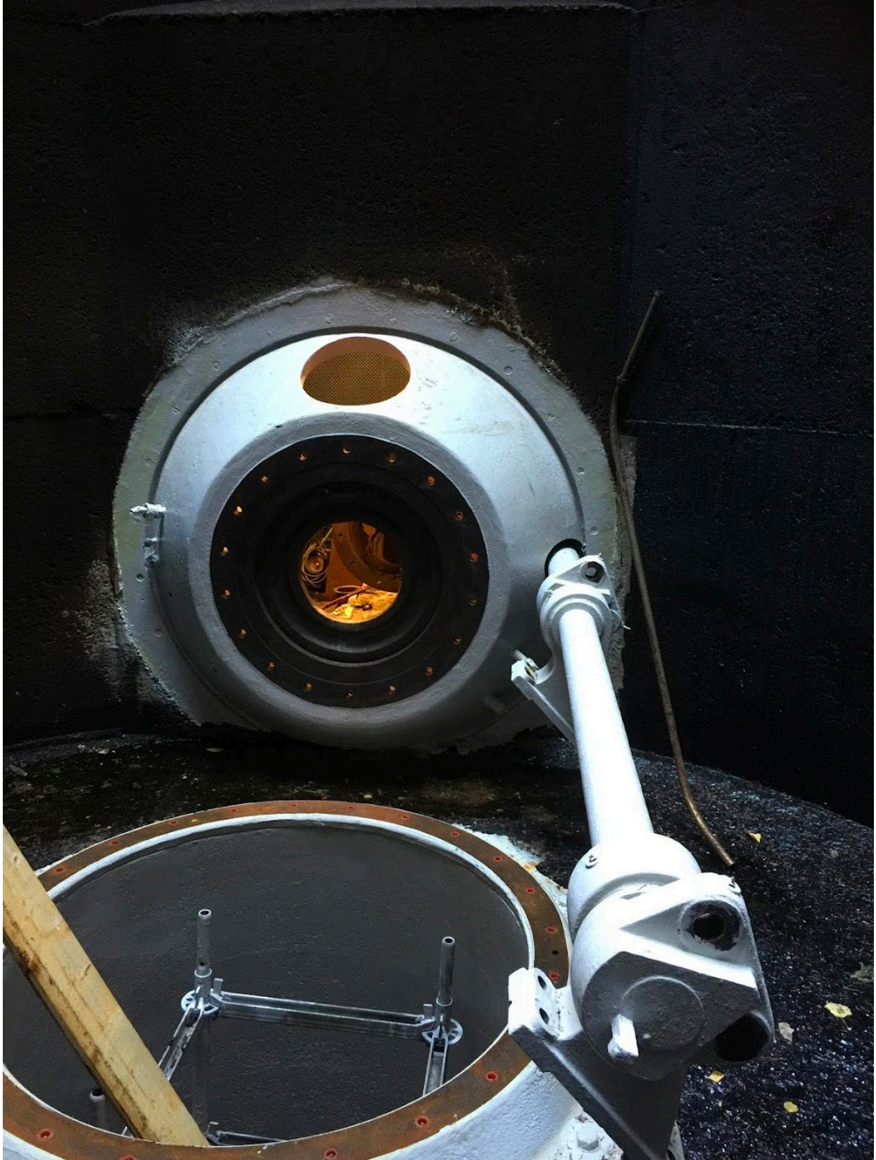
Interiör från tornet med turbinen borttagen.
