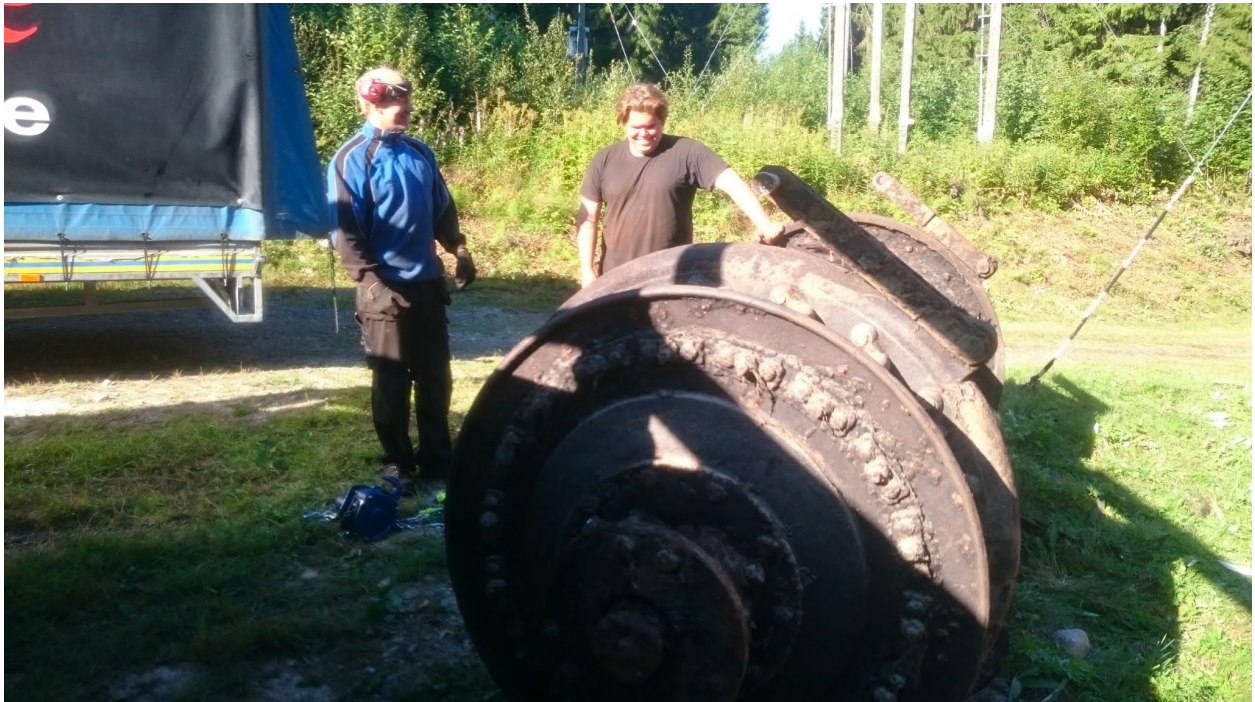
Turbinen är utlyft.
