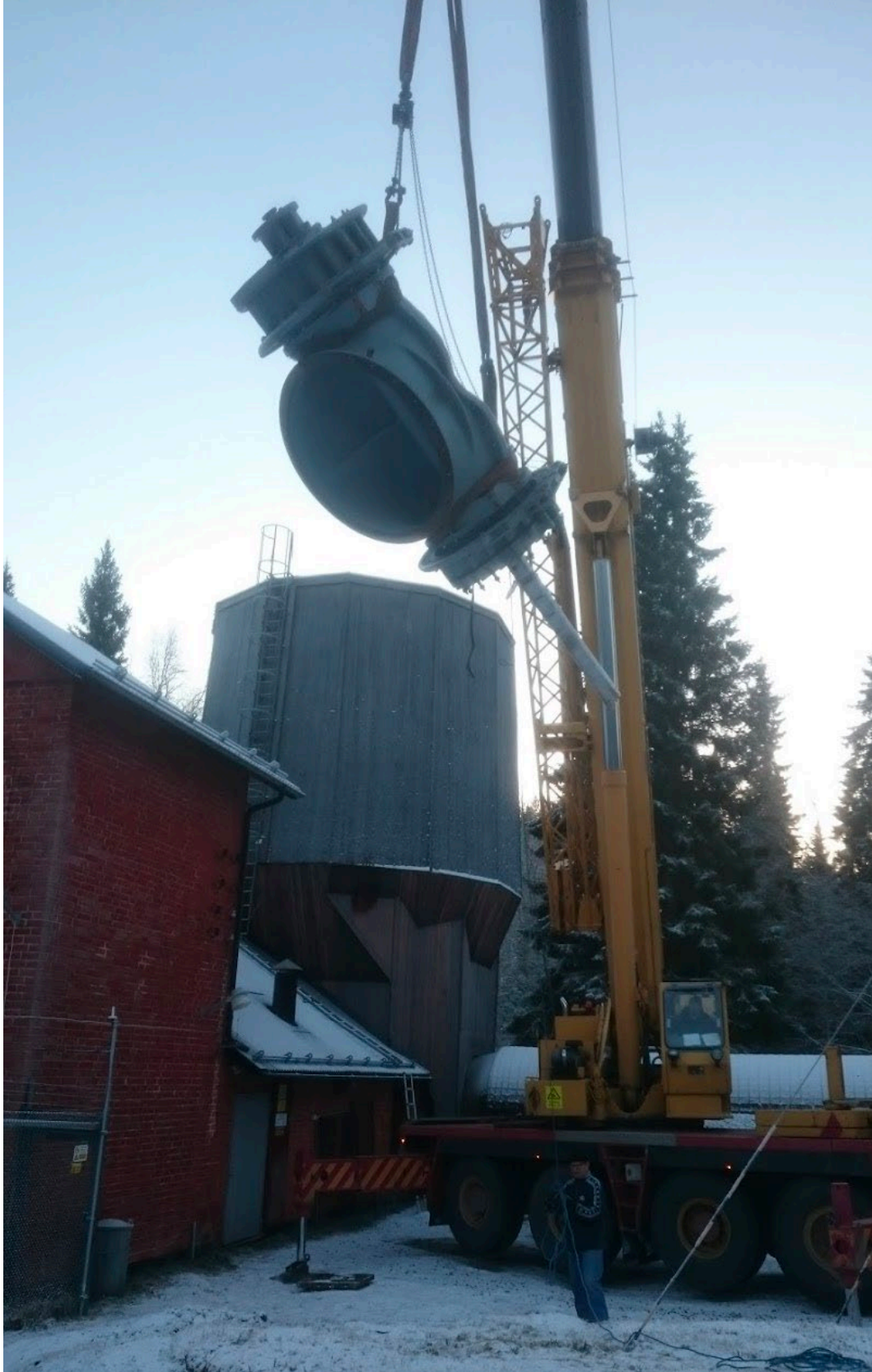
Turbinen lyfts tillbaka efter renovering.
