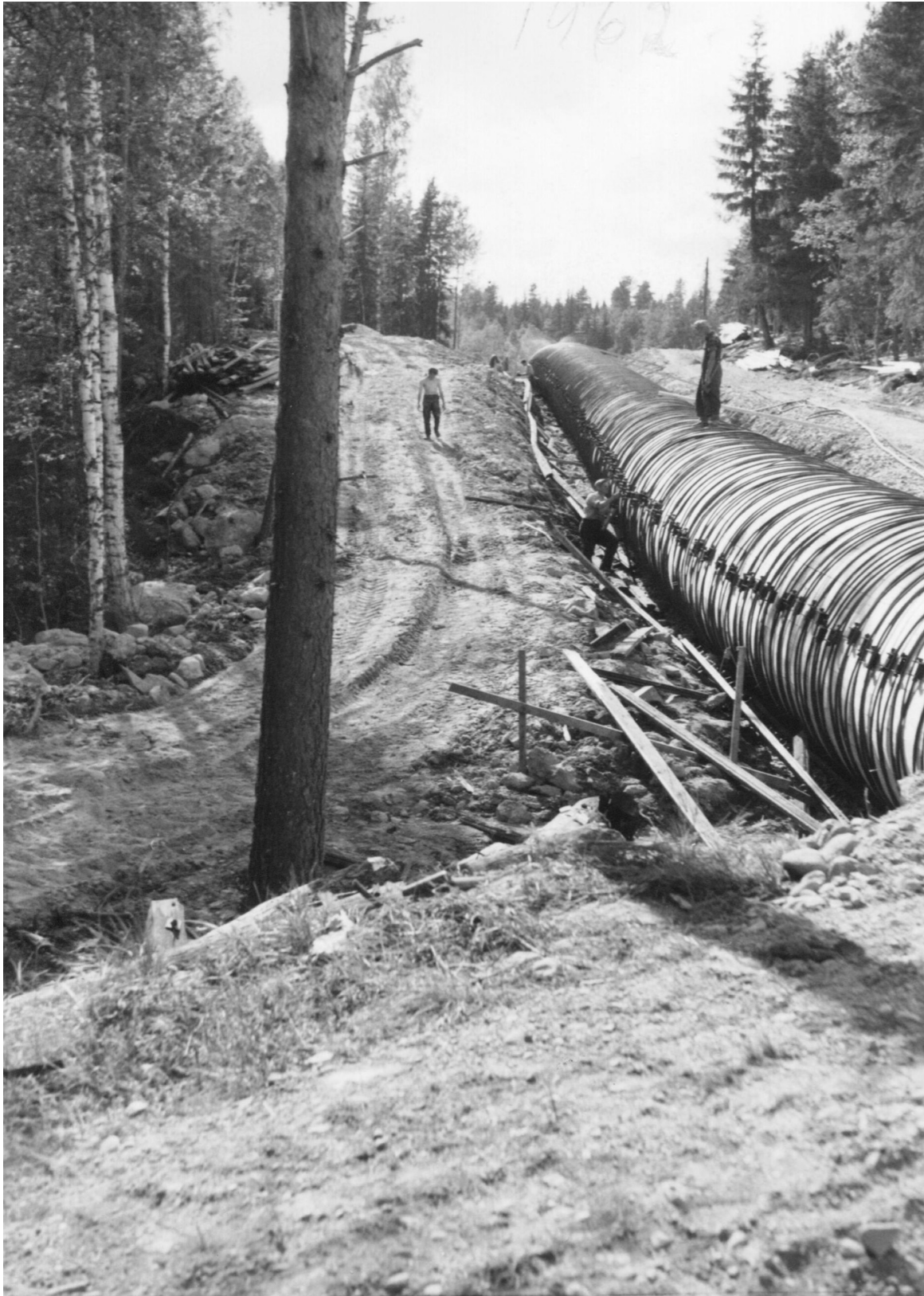
Foto från Gunnar/Ingvar Sjöberg. Byte av trätub. På fotot är skrivet 1962.
